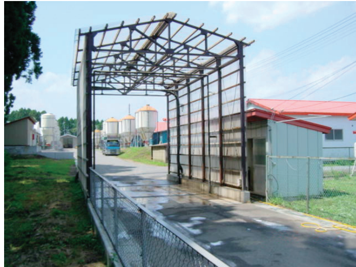
図5 養豚場に設置された車両洗浄消毒施設。(呉 克昌原図)
